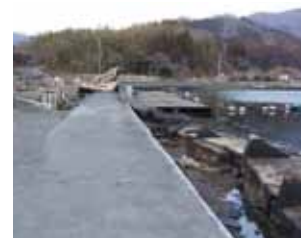
写真4 防潮ライン被災状況 大船渡港屋前地区
