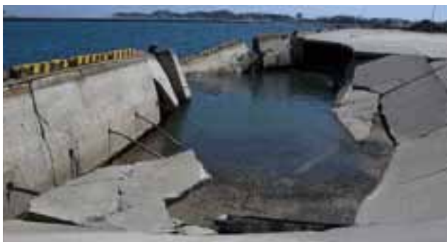
写真6 埠頭部分が大きく陥没した相馬港
