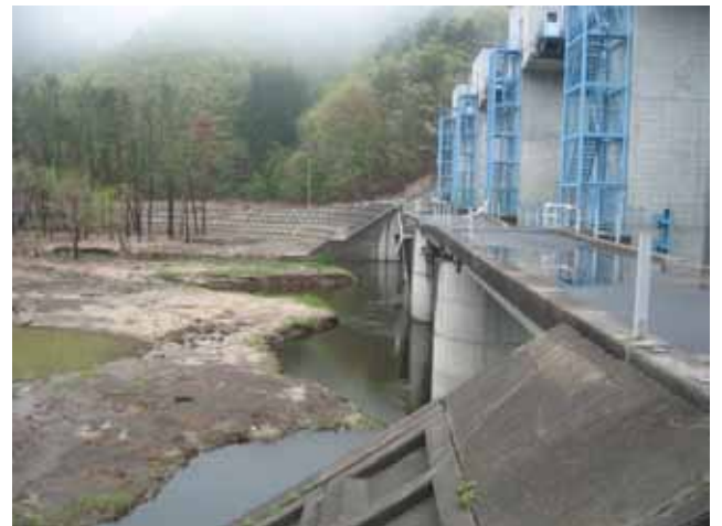
写真10 普代水門 15m(前面16-20m、後面10m程度)
