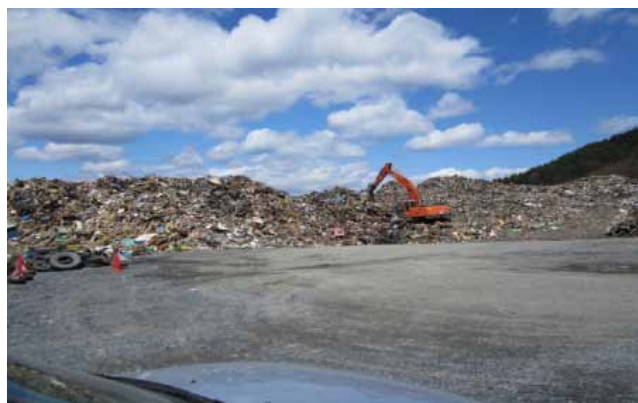
写真3 がれきの処理状況
