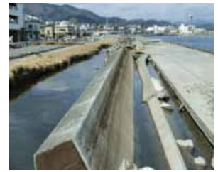
写真2 防潮ライン被災状況 大船渡港屋前地区
