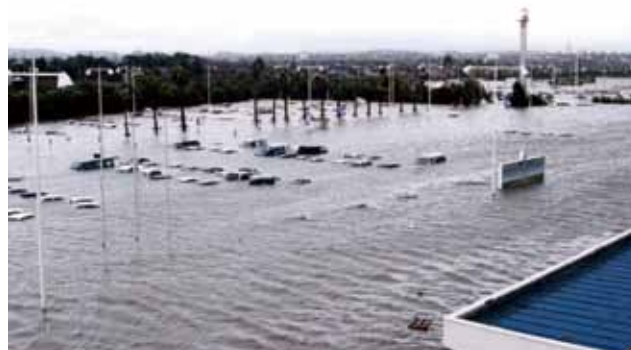
写真19 台風18号による高潮・高波災害(山口宇部空港駐車場)
