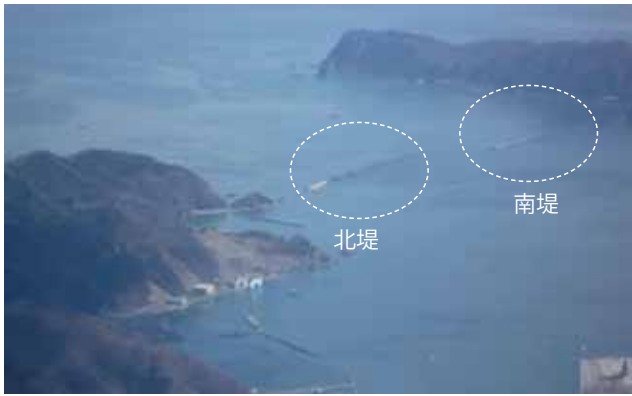
写真12 釜石湾口防波堤の被災状況
