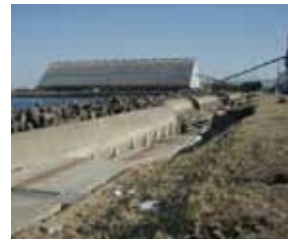
写真1 防潮ライン被災状況 八戸港八太郎地区
