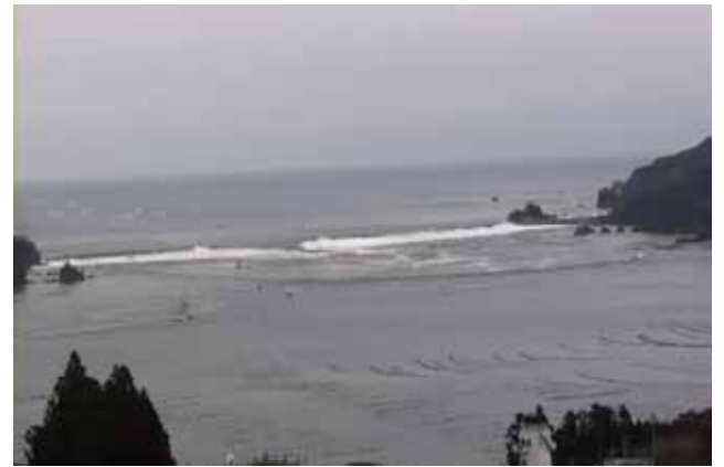
写真17 大船渡湾口防波堤 津波作用時の越流状況
