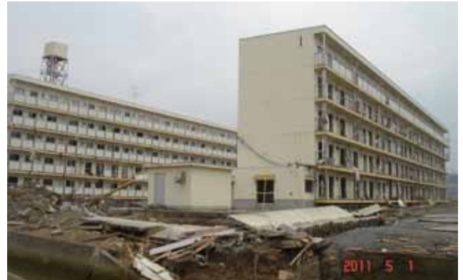
写真3 陸前高田(被災したアパート)
