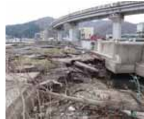
写真3 防潮ライン被災状況 釜石港須賀地区
