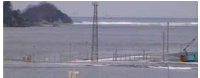
写真15 釜石湾口防波堤 津波作用時の越流状況 (東北地方整備局釜石港湾事務所撮影)
