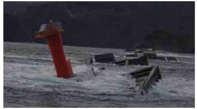
写真14 釜石湾口防波堤北堤(被災後)
