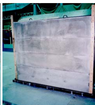
写真-4 充填状況(ケースUL)
