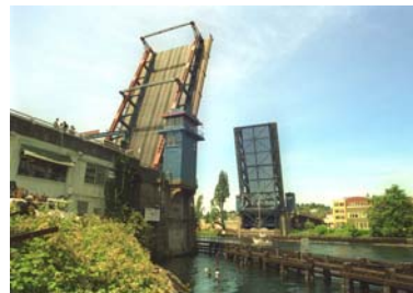
写真-1 跳開橋 (Fremont 橋, シアトル)
