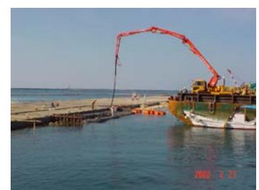
写真-2 天端打設遠景
