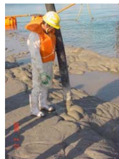
写真-1 天端打設近景
