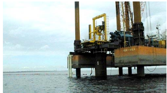
写真-3 基礎施工状況
