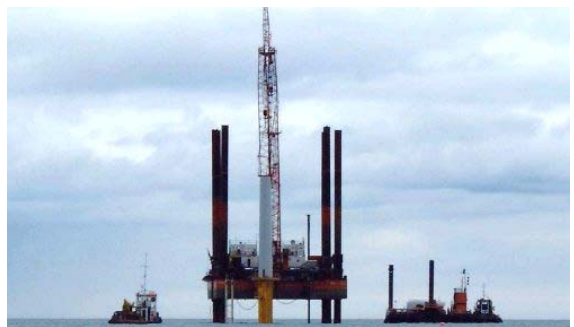
写真-4 風車 (タワー部) 設置状況
