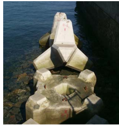
写真-4 消波ブロック 1)
