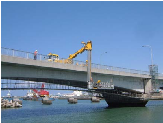
写真-1 特殊作業車による作業状況
