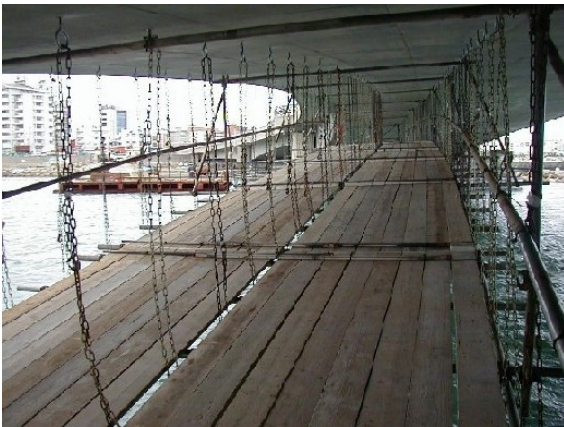
写真-2 吊り足場設置状況
