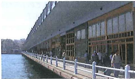
図-8 新ガラタ橋アプローチ部
