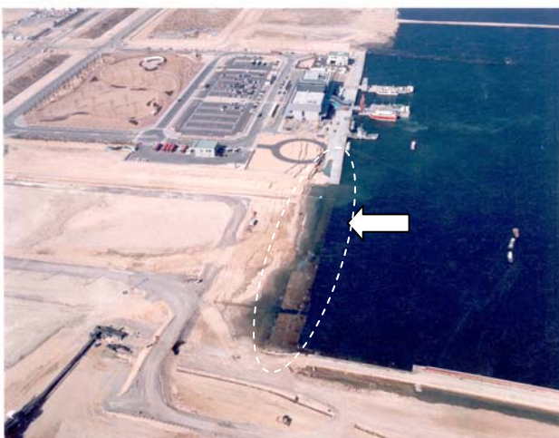
図-1 兵庫県南部地震でのケーソン式係船岸の被災例(ポートアイランドFバース)
