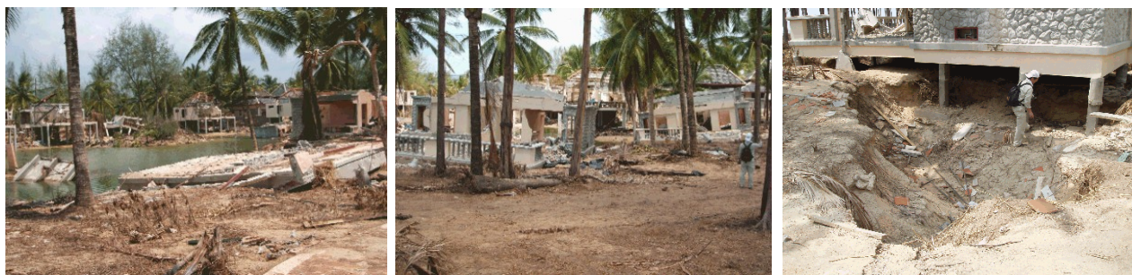
図-7 コテージの崩壊状況
