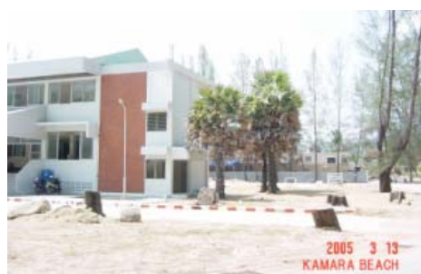
図-5 堅固な構造の警察署の建物
