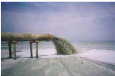
写真-1 浚渫土砂の投入状況
