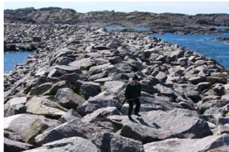
写真-2 シーレボーク港バーム防波堤(堤頭部より)
