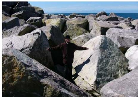
写真-3 シーレボークバーム防波堤の断面I部の捨石
