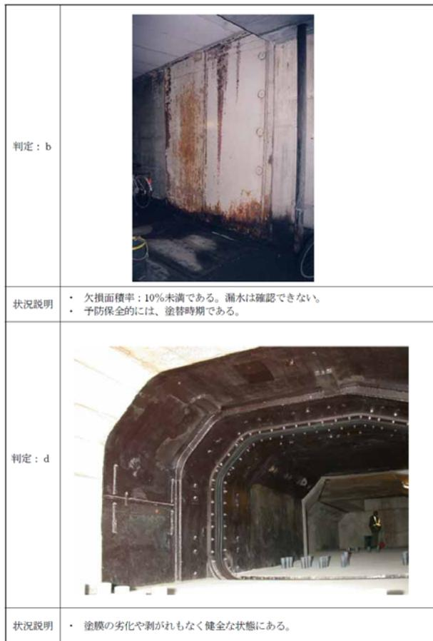
写真-1 劣化度判定参考写真例
