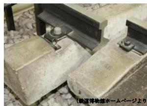
写真-1 奥：新幹線の PC マクラギ 手前：在来線のマクラギ
