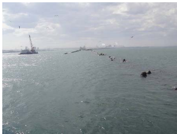
写真-1 八戸港の中央防波堤の被災
