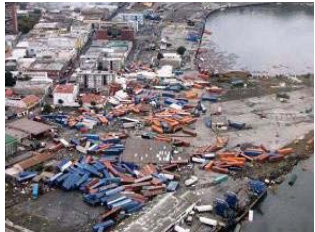
写真-3 タルカワノ港におけるコンテナの散乱状況
