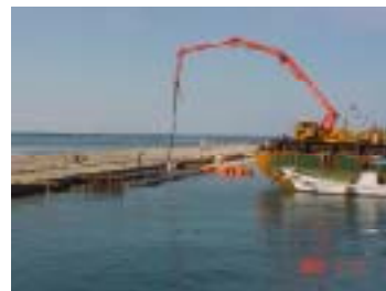
天端打設遠景
