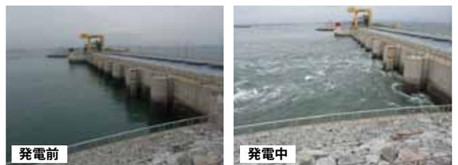
写真3 発電中の水面状況
