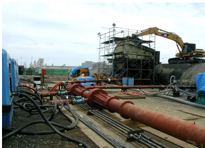
写真-1 トルネードミキシング工法配管状況
