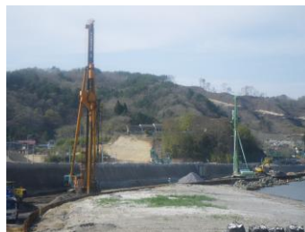
写真-3 陸上施工の事例（岩手県）
