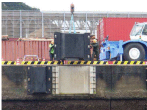
写真-1 取付台座設置状況
