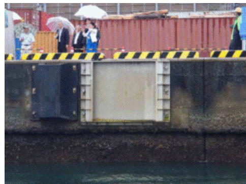
写真-2 防舷材取付状況
