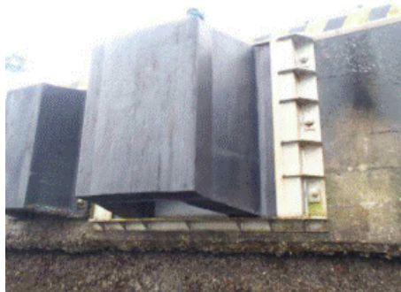
写真-3 防舷材設置完了
