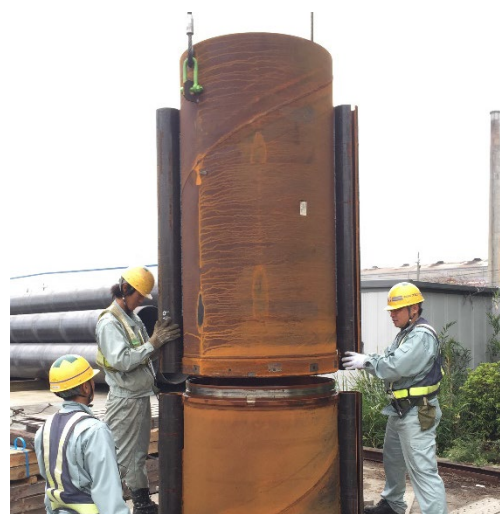
写真 1 ラクニカンジョイント (ステップ型)の施工状況
