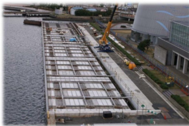
図-3. PC-Unit 栈橋工法®の適用例
