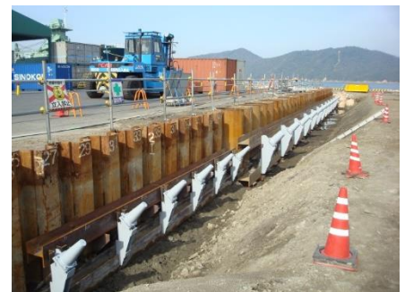
E H D アンカー施工例
