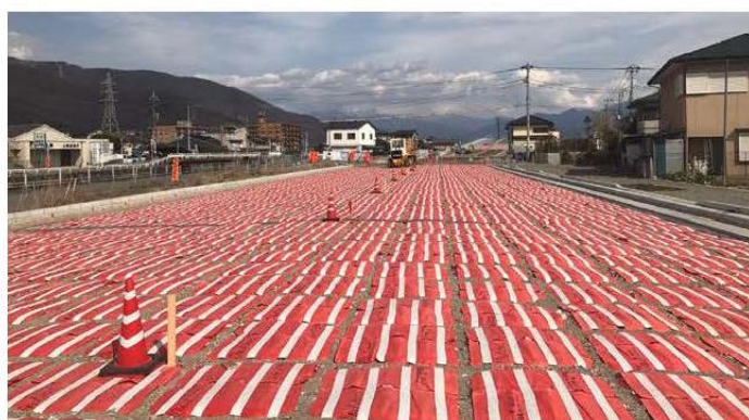
甲府市内のバイパス工事での路盤補強と振動対策(水) 2017年3月
