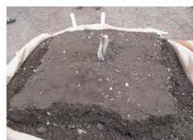
吊上後の中詰状況
