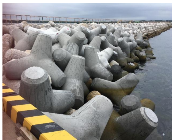
設置後9年経過状況
