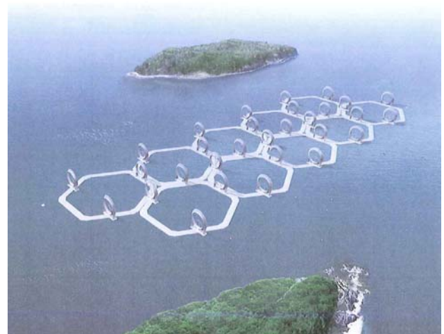
図-2 六角形浮体による大規模洋上風力発電のイメージ
