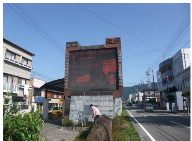
図-1 大型防災情報表示板（須崎港）
