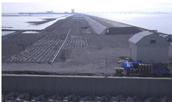
写真-1 施工状況写真（2012/11/22 撮影）
