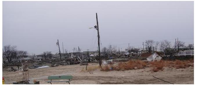
図-17 Breezy Point における高潮浸水で生じた漏電火災による家屋の焼失
