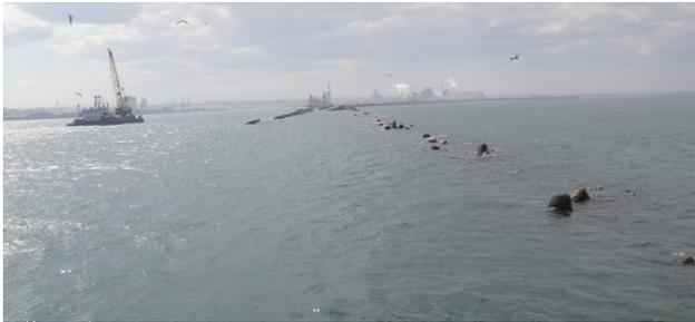
図-1 八戸港北防波堤中央部の被災状況
