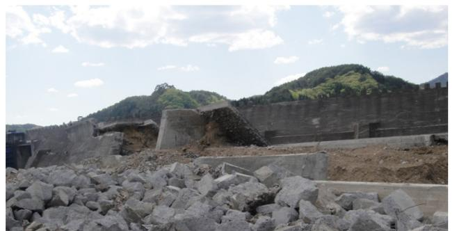
図-6 田老町の防潮堤の崩壊
