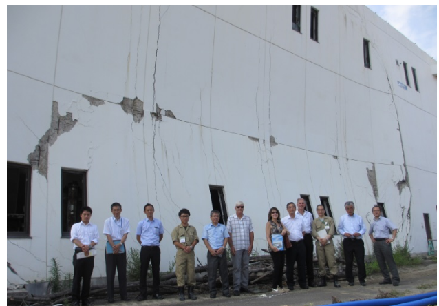
図-9 津波で被災した仙台市の浄化センター前での視察団一同
