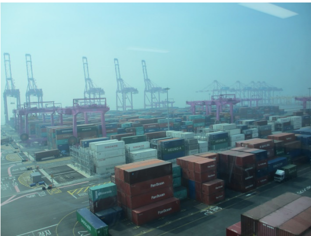
図-14 仁川新港のコンテナターミナルの全景
