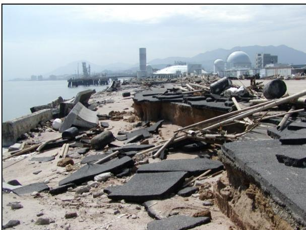
図-5 台風 0418 号による広島港廿日市埋立地の護岸被災
