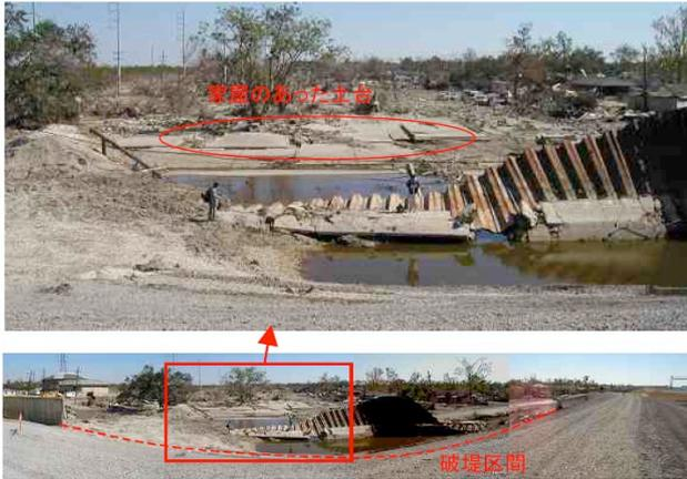
図-1 Inner Harbor Navigation Canal における防潮堤の破損状況
