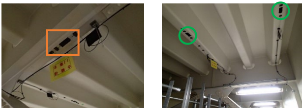
図-3 WIM システム ひずみ計の配置イメージ
