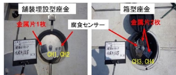
写真-3 腐食環境センサーの設置状況
