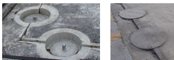
写真-2 舗装埋設型座金(左：蓋掛け前, 右：蓋掛け後(舗装前))
