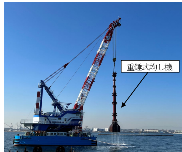
図-1 基礎工（機械均し）施工状況
