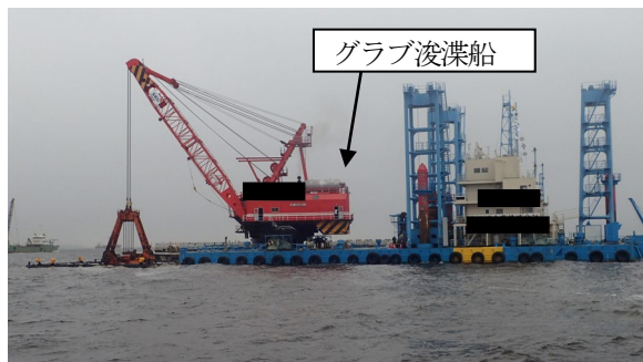
図-2 床掘工施工状況
