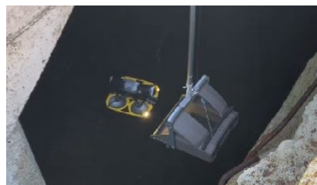
写真-7 回転翼UAVによる調査状況
