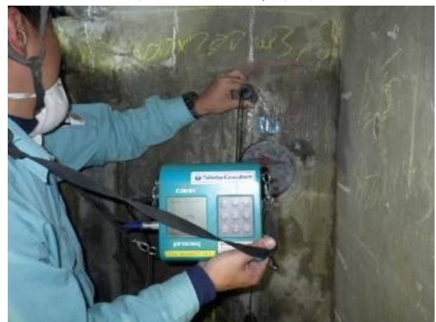
写真-2 自然電位測定
