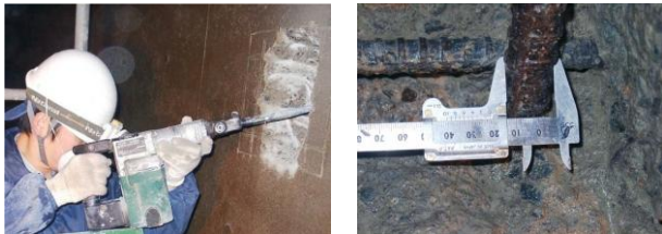
写真-3 はつり調査による鉄筋腐食量調査
