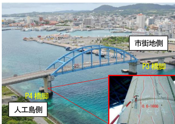
写真-1 サザンゲートブリッジ全景
