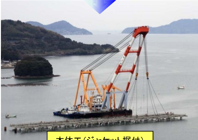
本体工(ジャケット据付)
