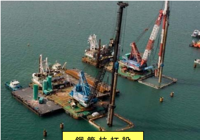
鋼管杭打設
