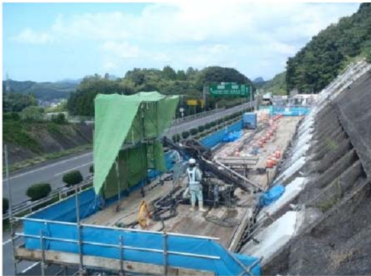
アンカー削孔
