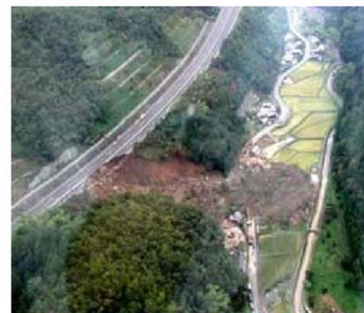
(のり面災害状況)
