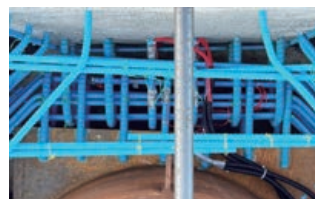
小径ループ継手 (配力鉄筋配置後)
