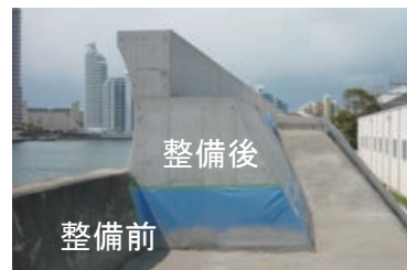
図1 海岸の地震・津波対策 (和歌山下津港海岸)
