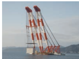
写真1 吊降し方式
