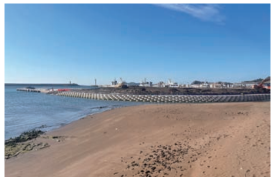
工事中の親水護岸
