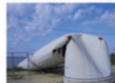
タワーの倒壊
