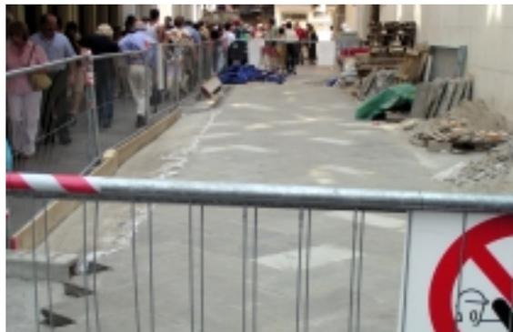
写真 - 5 局地的な対策である道路高上げ工事
