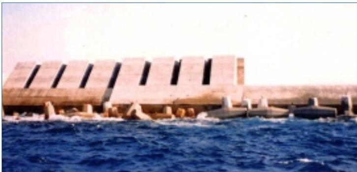
図 - 5 那覇港の上部斜面ケーソン堤 (沖縄総合事務局提供)
