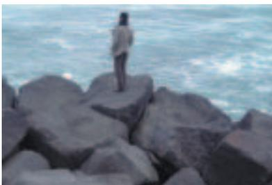
写真9 グランドビーク港バーム防波堤(捨石大きさの状況)
