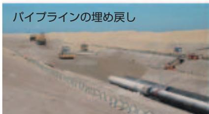
写真1 パイプラインの敷設と埋め戻し
