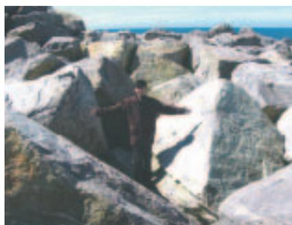
写真3 シーレボーク港バーム防波堤の捨石(堤頭部、断面I)
