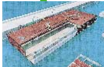
沈埋函製作 (沖縄)
