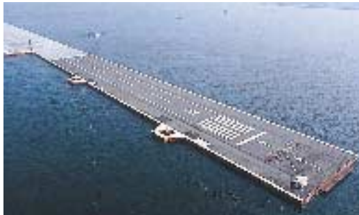
神奈川県横須賀沖で実証実験が行われたメガフロート
