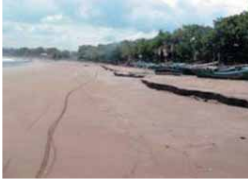
写真-2 Pangandararanの海岸(侵食の跡とボート)
