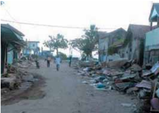
写真-5 海岸から内陸への道沿いの家屋(木造の家は無くなっている)
