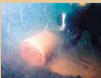
ダイバーによる敷設
