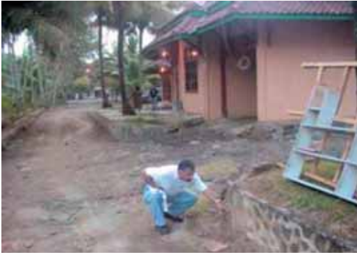
写真-8 宿泊したホテル付近 (床下浸水)
