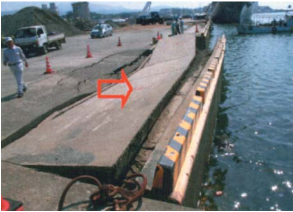
写真 - 7 中浜埠頭 沖側岸壁の移動
