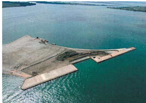
写真-8 人工島全景 (北側水路のアバット) HPより
