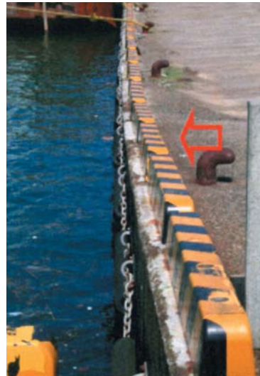
写真 - 6 東埠頭物揚場の移動
