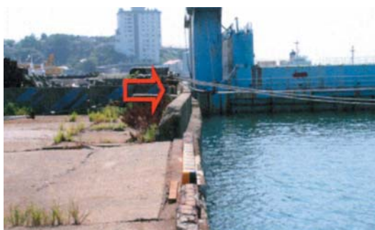
写真 - 5 東埠頭 沖側護岸の移動
