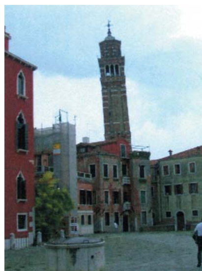
写真-2 不同沈下により傾く鐘楼
