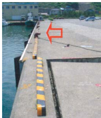
写真 - 4 中央埠頭 東側物揚場の移動
