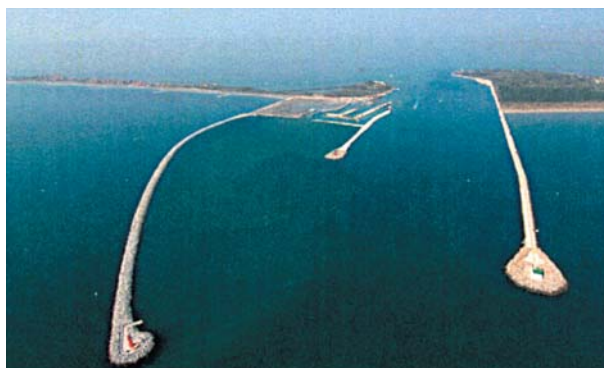
写真-6 マラモッコ水路の現状 (アドリア海側より) HPより
