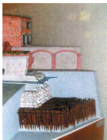
写真-1 建築物と木杭
