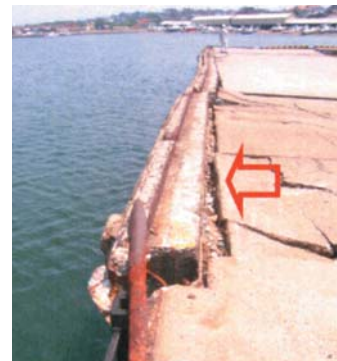
写真 - 3 中央埠頭 沖側護岸の移動
