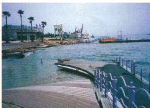
写真2 岸壁背後の沈下
