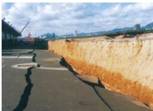
求性能を満たすようにFEM等で検討するが、要求性能を満たすためには地盤の液状化対策が必要となることが多い。ただし、L2地震動に対しては液状化の発生は認めており、液状化の発生を完全に防ぐのではなく岸壁の変位等が許容値に収まるように対策仕様が決定される。
