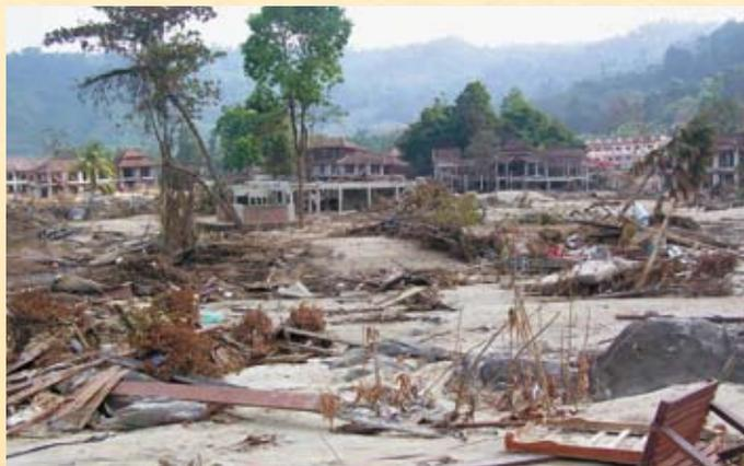
前面の建物によって被災程度が軽減された例 (Matsutomi et al., 2006)
