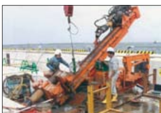
重力式岸壁の補強例
