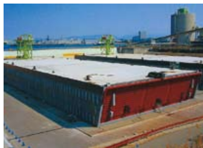
写真1 キーエレメント (大阪港夢咲トンネル)
