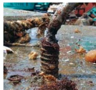
写真1 すきま腐食により劣化した綱環
