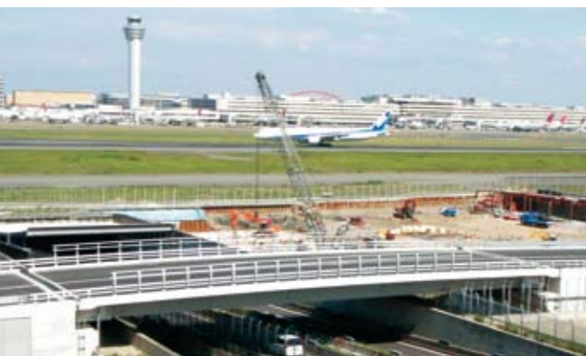
写真1 GSE橋梁全景
