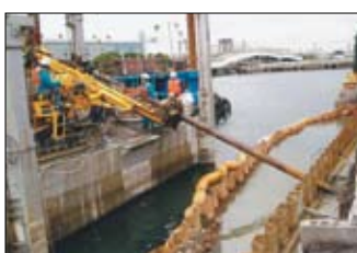
鋼矢板岸壁の補強例
