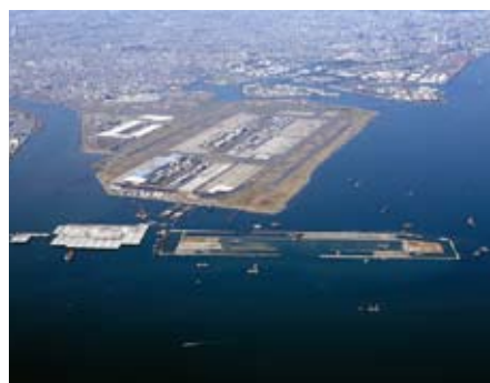
写真2 羽田D滑走路築造工事全景(国土交通省HPより)
