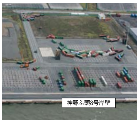
写真7 高潮により散乱したコンテナ (中部地方整備局撮影)
