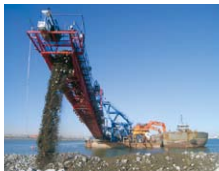
写真3 鉄鋼スラグ水和固化体(フロンティアストーン®)による埋立
